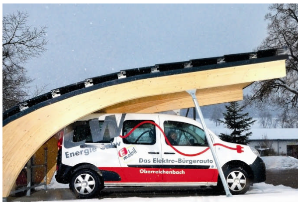
Das Elektro-Bürgerauto im Solarport
