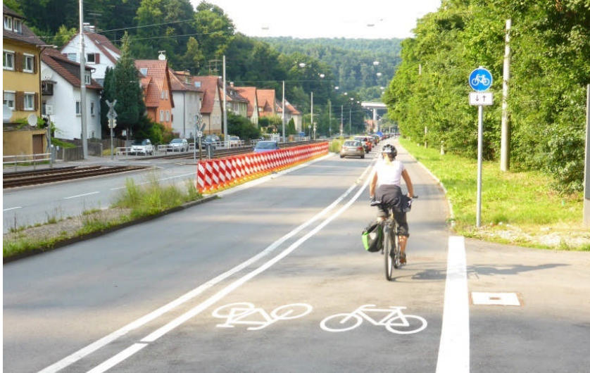
Böblinger Straße nach dem Ausbau zur Hauptroute
